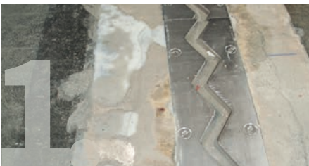
Schadhafte Metallfuge
