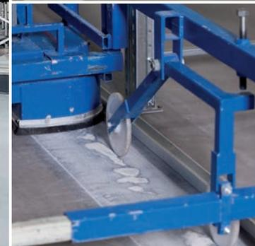
**Fahrgassenpräzisionsschliff nach VDMA- Guideline im Neubau:**
