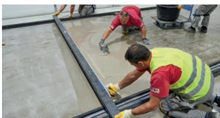
Einbau der Nivellierschicht
