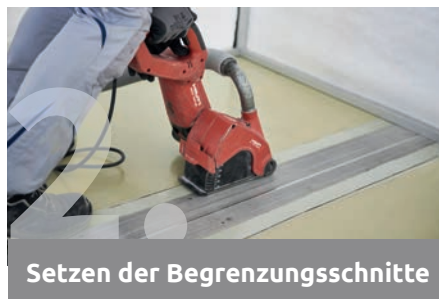
Entfernen der alten Metallfugen
